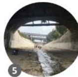
5 Arroyo Seco Confluence 2018 & 2019
