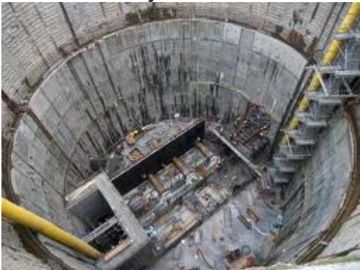
Portland CSO Project Shaft
