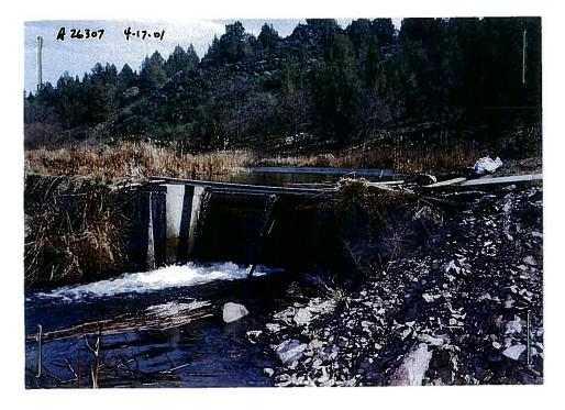
ORIFICE IS IN BOTTOM BOARD
